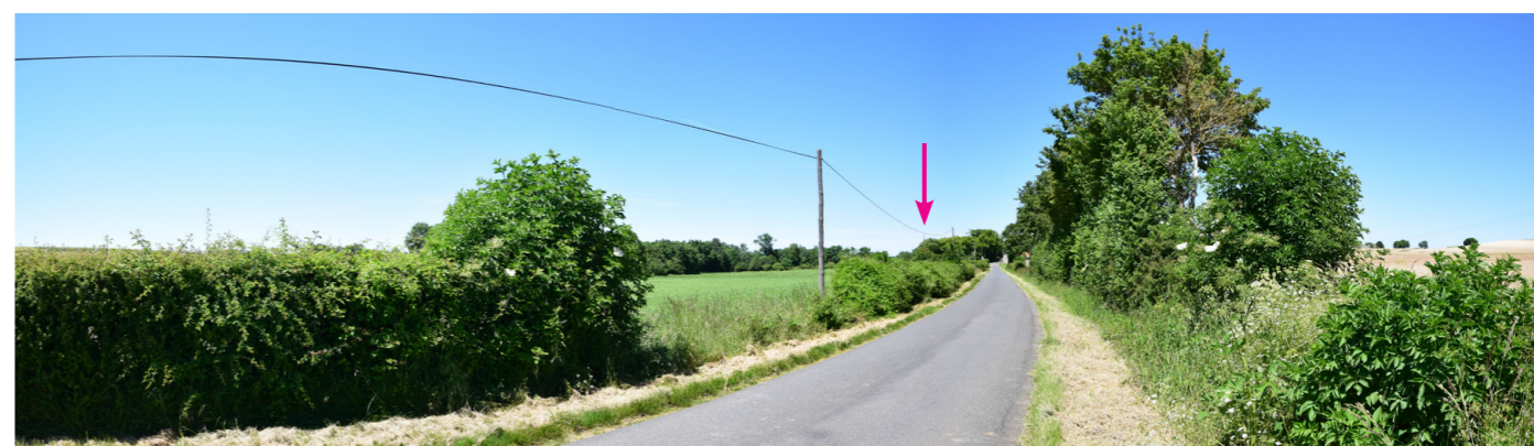
Fig. 95 : Vue sur l'église dans l'axe de la D66
