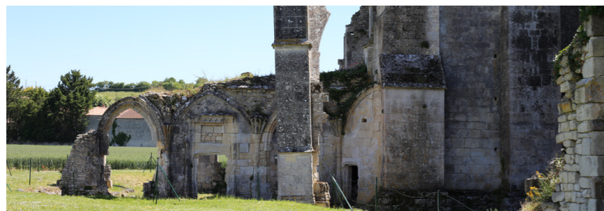
Fig. 83 : Restes du cloître à l'arrière de l'église
