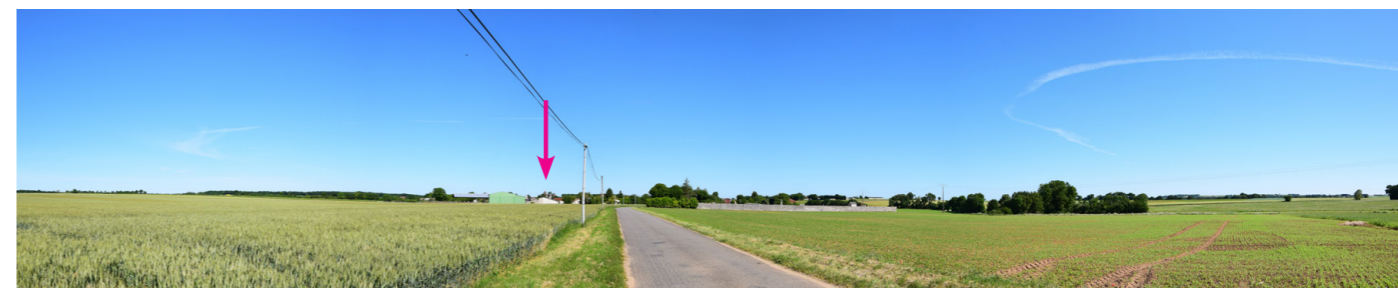
Fig. 124 : Vue depuis l'entrée de Barbezières sur l'église et le château
