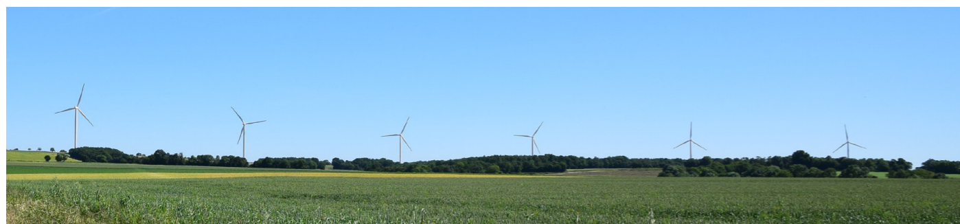
Fig. 76 : Parc éolien de Xambes-Vervant
